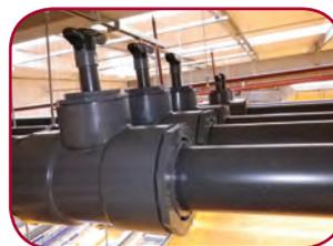
Centra-Lok™ permet un assemblage rapide tout en garantissant une cohésion inégalée. Le contrôle des fuites potentielles peut être assuré visuellement ou par des capteurs automatiques.
